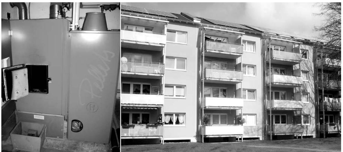
Eine der neuesten Solarsiedlungen der GAG in Köln-Ossendorf: Die Häuser sind gedämmt und mit Solarthermie und Pelletheizungen ausgerüstet
