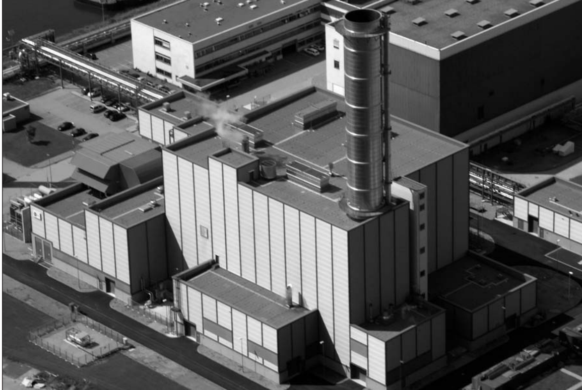
Das neue GuD-Kraftwerk in Niehl spart im Jahr 200.000 t CO 2 gegenüber seinem Vorgänger ein
